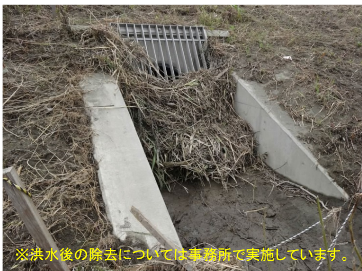
洪水後の呑み口（2015-09）
