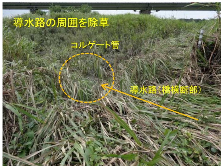
導水路の橋横断区間
