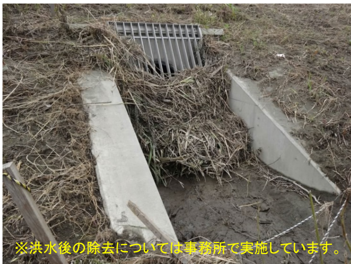
洪水後の呑み口（2015-09）
