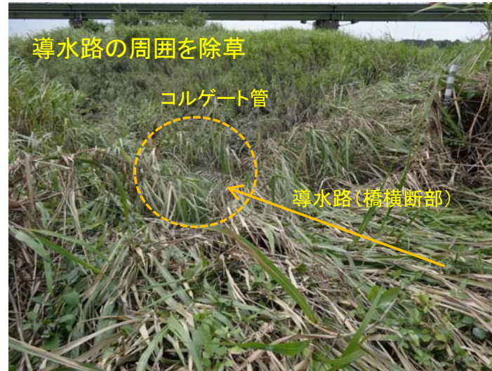
導水路の橋横断区間
