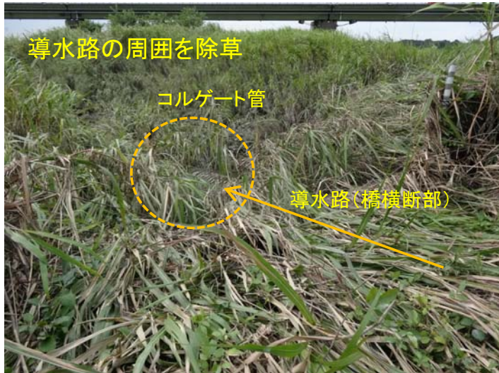
導水路の橋横断区間
