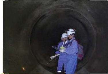
② 導水トンネル
