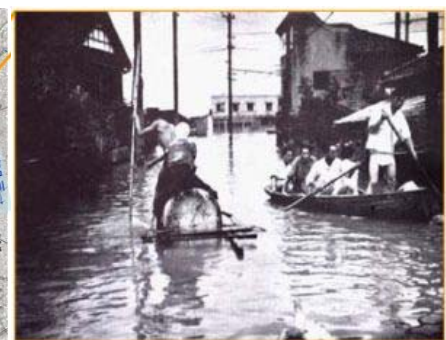
葛飾区本田四ツ木町の浸水状況「東京都水害誌」より
