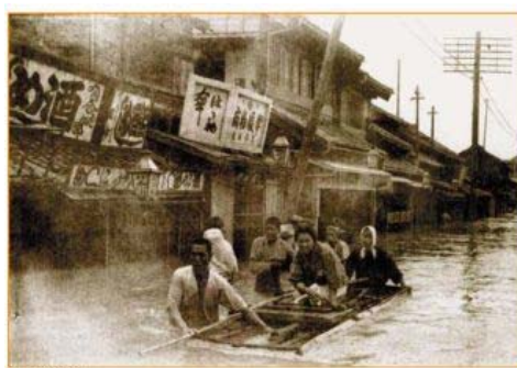
本所南割(現在の錦糸町)付近の状況。浸水深5尺(約1.5m)余り
