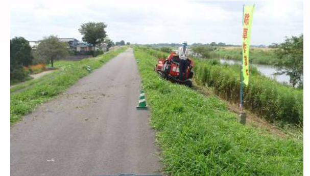
堤防の除草状況
