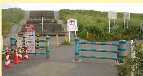
車両通行止め状況
