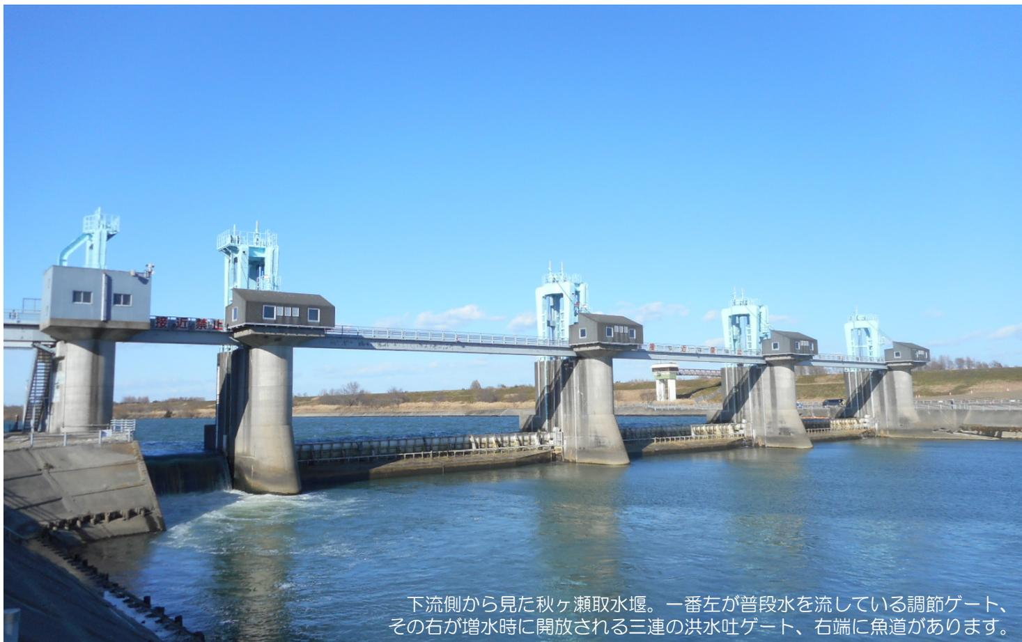
下流側から見た秋ヶ瀬取水堰。一番左が普段水を流している調節ゲート、その右が増水時に開放される三連の洪水吐ゲート、右端に魚道があります。
