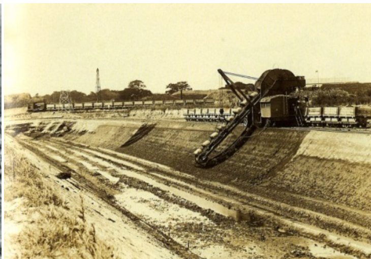
機械動力による施工
