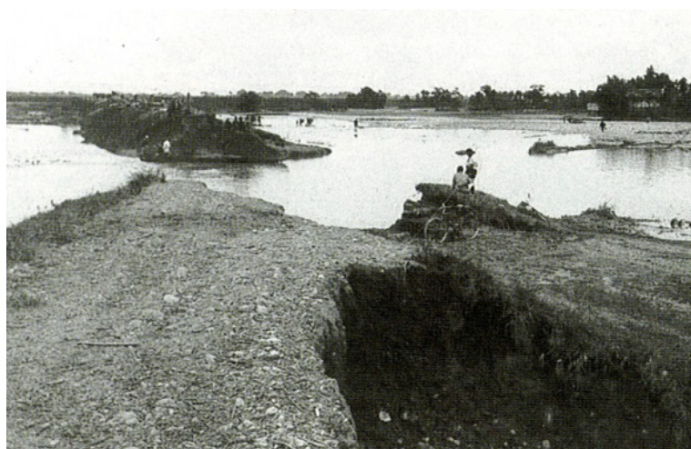
堤防決壊の光景（熊谷市村岡付近）
