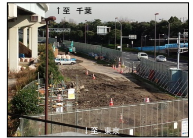
写真②:舞浜立体海側 橋梁下部工事
