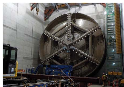
写真①:シールドマシン到達状況【台場側立坑】 (平成29年1月17日貫通)
