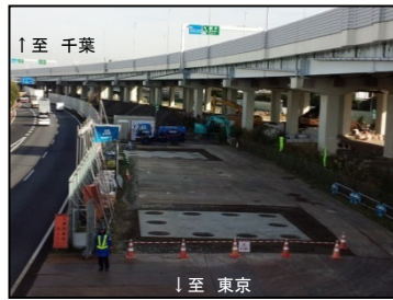
写真①:舞浜立体山側 橋梁下部工事
