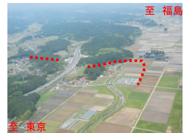
現況写真(矢板北PA付近)
