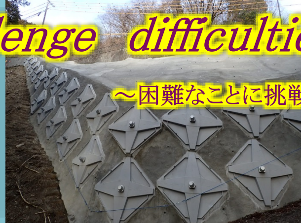
法面補強、グランドアンカー工法
