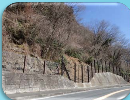
落石防護柵工
