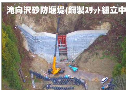
平成27年9月の関東・東北豪雨により、同時多発的に土石流が発生した日光市芹沢地区において、砂防堰堤6工事が工事の終盤を迎え、現在、鋼製スリット等の設置を行っております。
