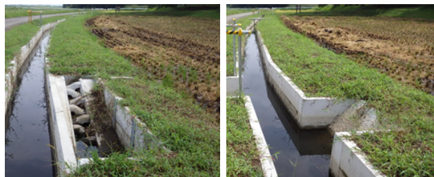
整備された魚道(左)とカエルスロープ(右)(野田市目吹地区)
