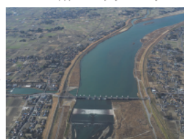
▲利根大堰を下流から望む
