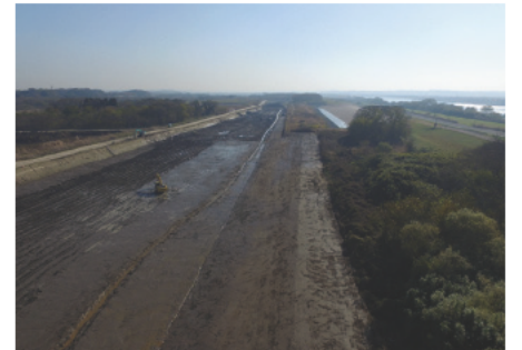
▲稲戸井調節池の掘削状況
