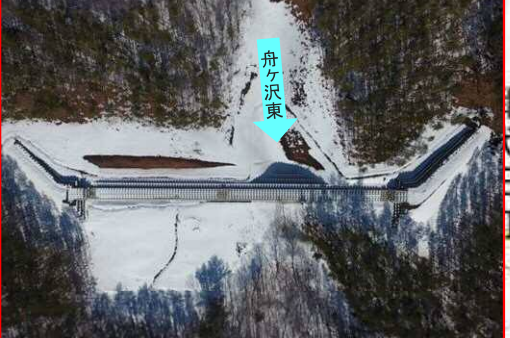
船ヶ沢東砂防堰堤
