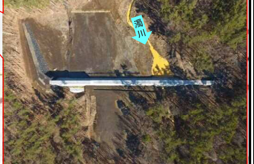
濁川砂防堰堤
