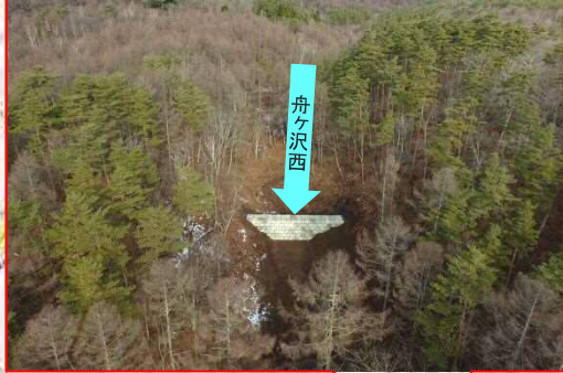
船ヶ沢西砂防堰堤
