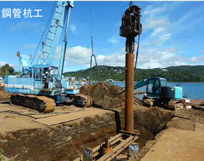
栈橋本体架設工
