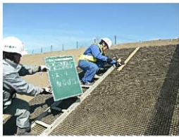
土木シート設置状況
