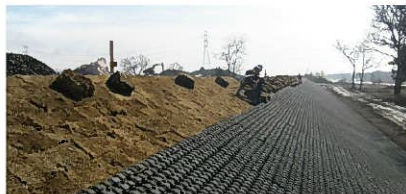
張り芝工の施工
