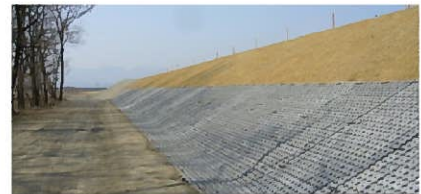
対策工の完了
