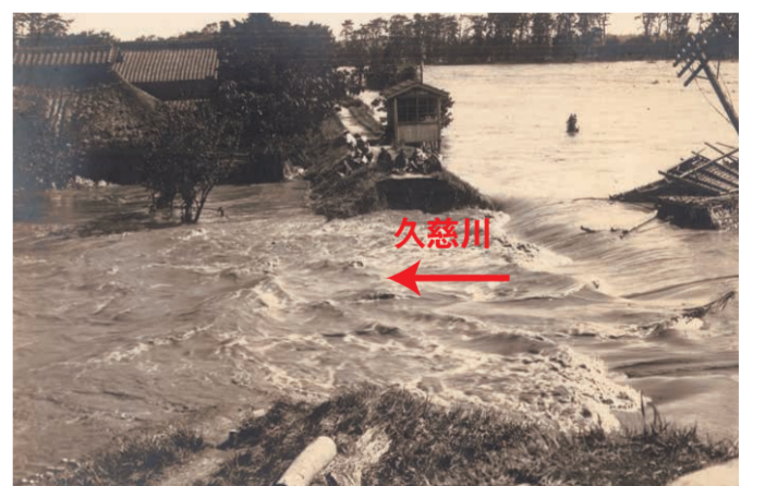
東小沢村の溢水状況(現日立市留地先)
