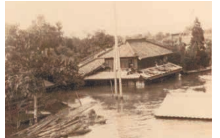
浸水した市街地(常陸太田市)
