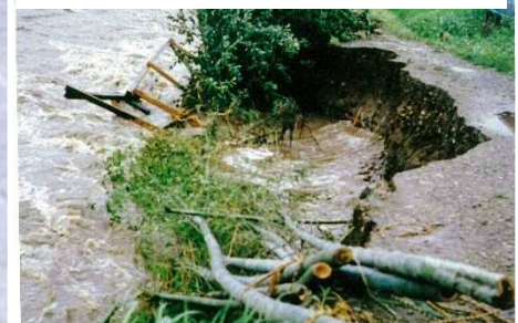
権津川_那珂川町小川地先 (旧小川町)
