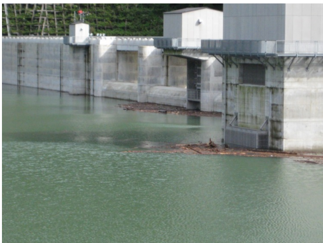
流木の捕捉状況(湯西川ダム; H27.9 台風18号時)
