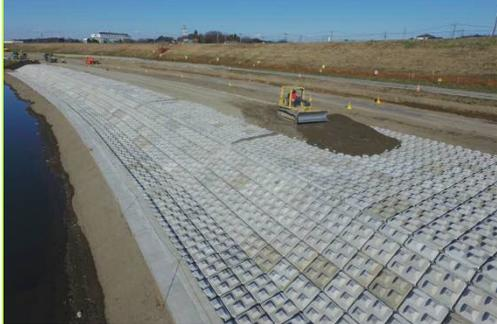
平成29年2月17日(金)時点の工事進捗率は計画92%に対して、実施92%の状況です。2/17(金)現在は、大型連結ブロック設置が完了し、砕石舗装及び覆土・撤出土・盛土を行っております。また、流山トラックは発生土の受入が完了し順次片付けを行い、吉川トラックにおいては引き続き受入を行います。残り1ヶ月半、最後まで安全作業を行ってまいります。
