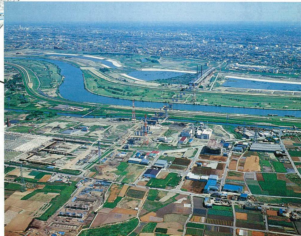
和光市側より戸田方向を望む
