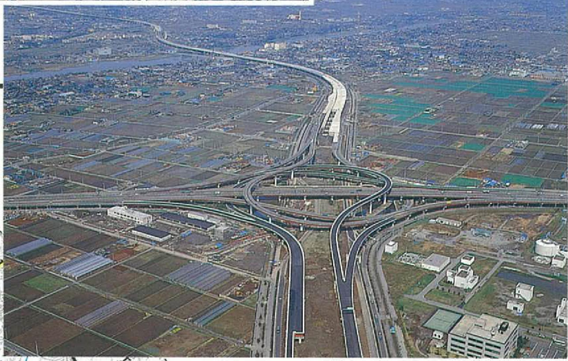
三郷インターチェンジより草加方向を望む
