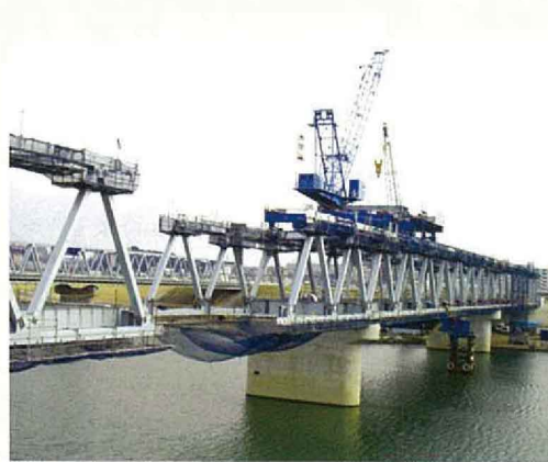
工事状況（外回り）
