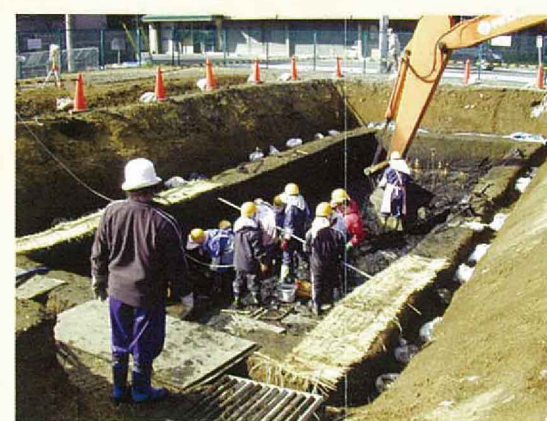
確認調査状況
