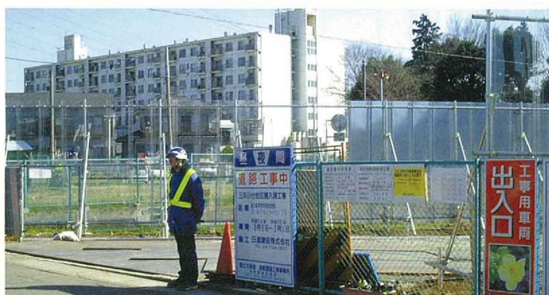
安全の確保状況（フェンスと保安要員を配置）
