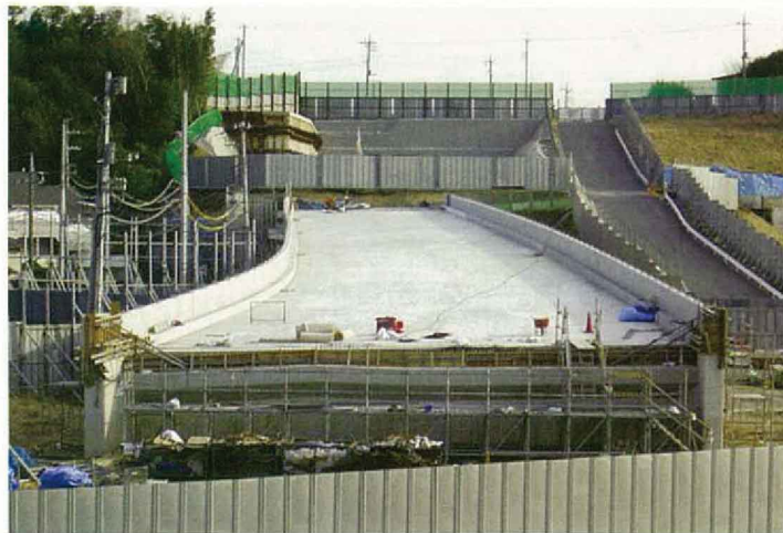
工事状況（矢切高架橋外回り）
