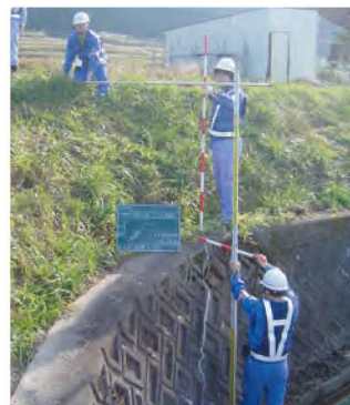
市町村道の災害復旧に向け、 災害箇所の調査を開始。
