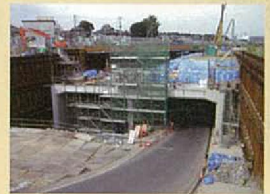
高速道路部分の工事
