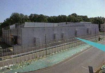
小塚山トンネル工事防音ハウス
