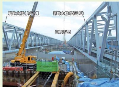
葛飾大橋(国道298号の内回り・外回り)の間に高速道路部が建設されます。現在、橋脚工事を進めています。
