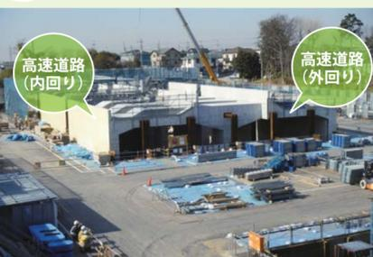
北総線の矢切駅～北国分駅付近は鉄道が地下を通過するトンネルになっています。北総線のトンネルに外環の掘削部(半地下構造)が影響を与えないよう慎重に工事を実施しています。
