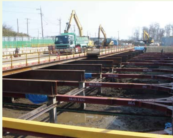
高速道路部(半地下構造)の建設に向け、掘削等の工事を進めています。
