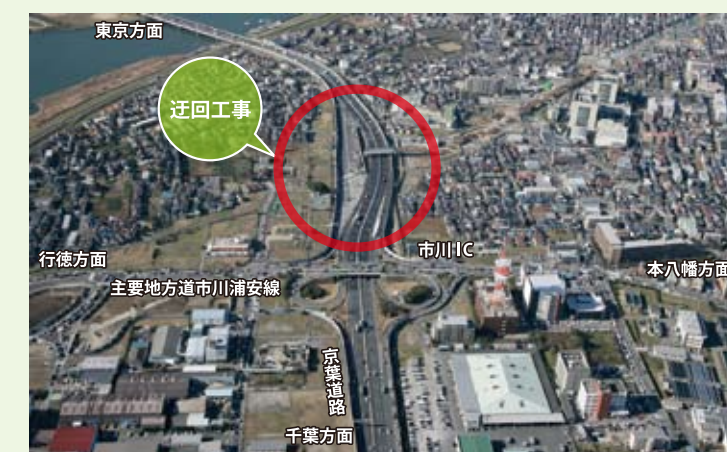
外環と京葉道路を結ぶ京葉ジャンクション(仮称)付近では、外環のトンネル部分を京葉道路の地下につくるため、一時的に京葉道路を本八幡方面へ迂回させ、外環工事を進めています。
