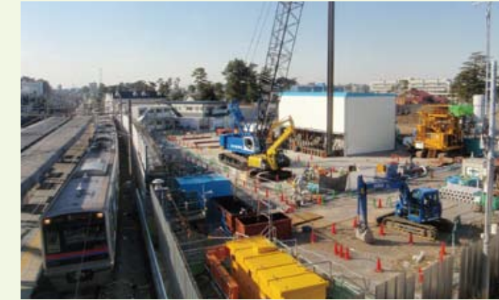
京成本線菅野駅付近(北側)
