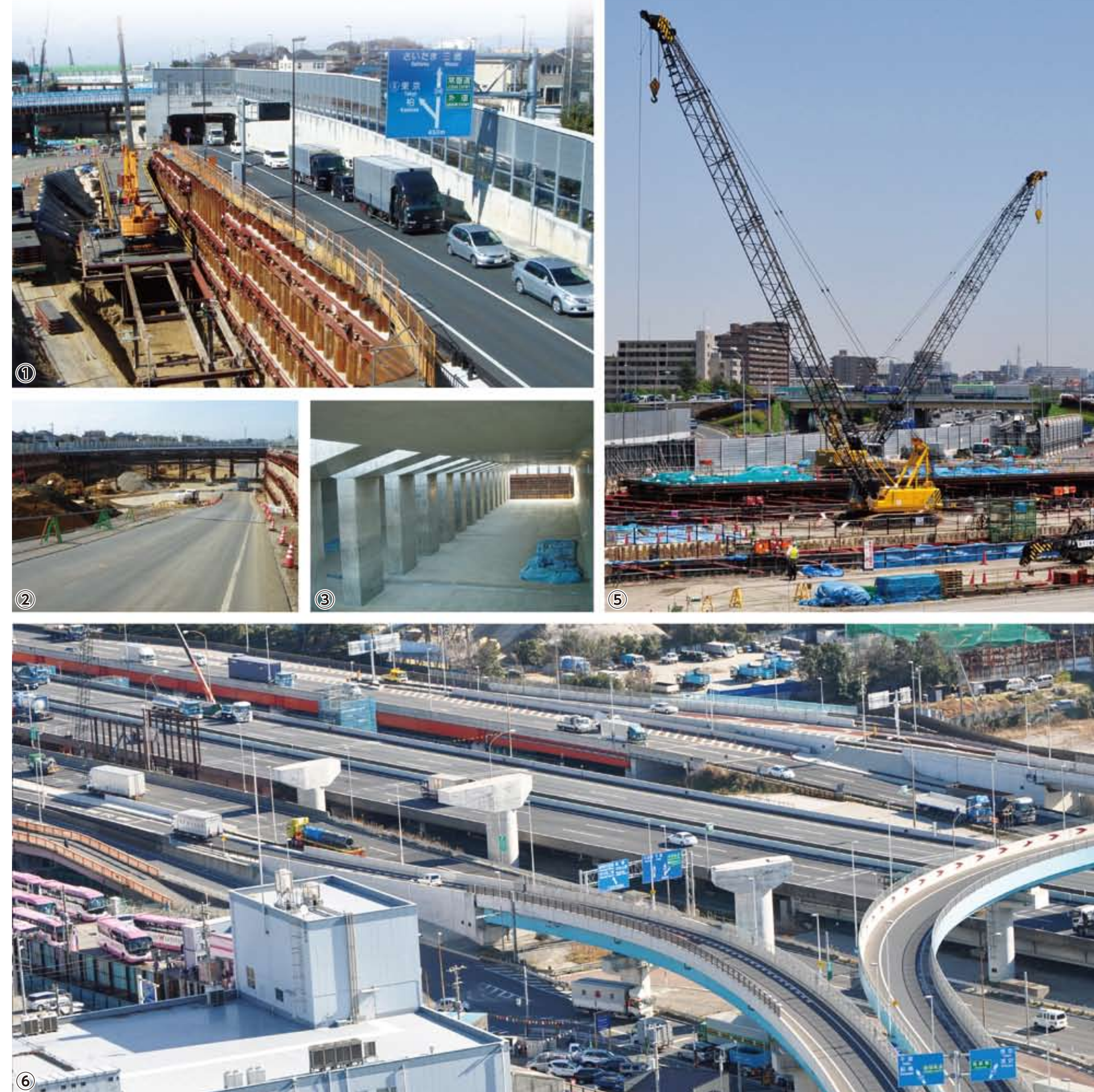
①松戸市上矢切付近 ②松戸市三小台付近 ③市川市北国分付近 ④市川市国分付近 ⑤市川市稲荷木付近 ⑥市川市高谷付近
