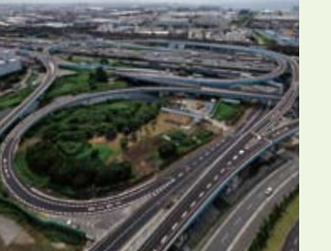
外環と東関東道・首都高速湾岸線を結ぶ高谷JCT(仮称)
