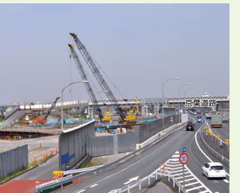
迂回させた京葉道路横で高速道路部をつくっています
