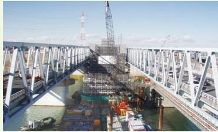
葛飾大橋(国道298号)の内回り外回りの間に高速道路部の橋脚を建設中です。
