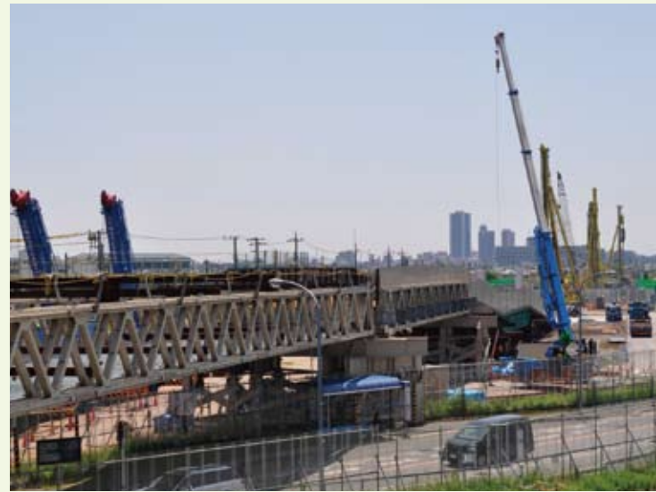
市川市国分地区では高速道路部(半地下構造)を建設するにあたり、地中連続壁(土留め工)の設置を進めています。平成23年5月には、県道高塚新田市川線をまたぐ工事車両専用の仮橋を架設しました。
