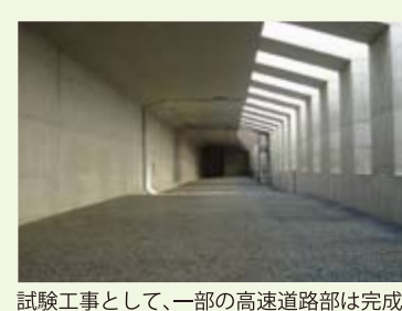
試験工事として、一部の高速道路部は完成
