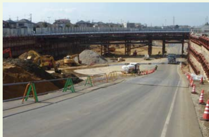
外環の高速道路部と国道部(内回り)のトンネル工事を進めており、一部完成しております。引き続き、外環の高速道路部(半地下構造)の工事を開始するための掘削等の工事を進めています。
