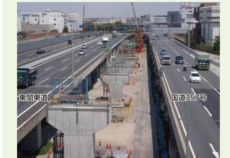
限られたスペース(幅:約10m)で橋脚の工事を進めています
