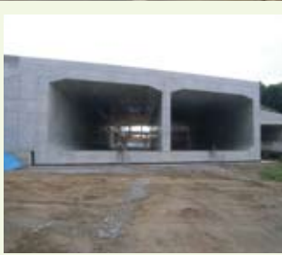
外環の高速道路部と国道部(内回り)のトンネル工事を進めており、一部完成しております。引き続き、外環の高速道路部(半地下構造)の工事を開始するための掘削等の工事を進めています。
