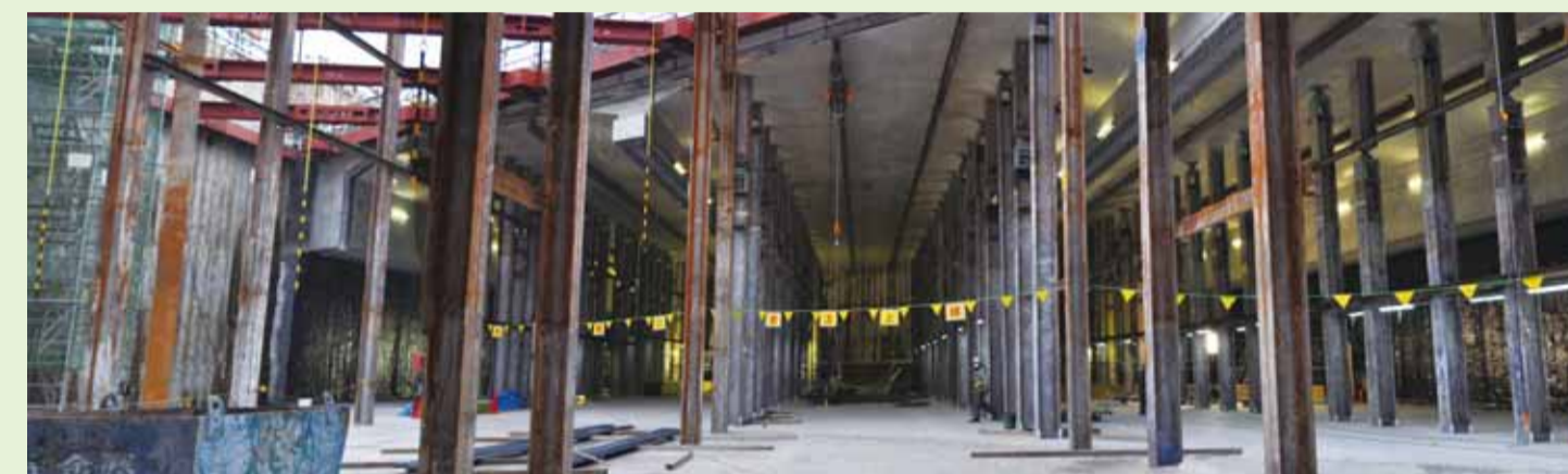
元の京葉道路直下につくられた高速道路部
