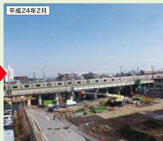
地上で外環の高速道路部となるコンクリート構造物を製作し、地下に沈めました。
