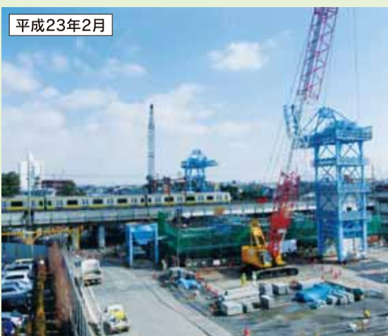
地上で外環の高速道路部となるコンクリート構造物を製作し、地下に沈めました。
