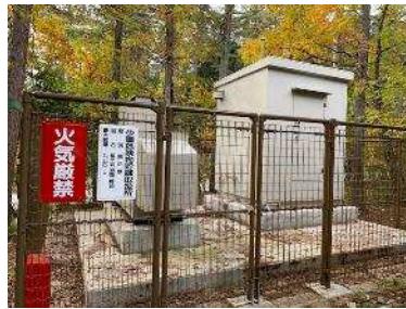
非常用電源設備
