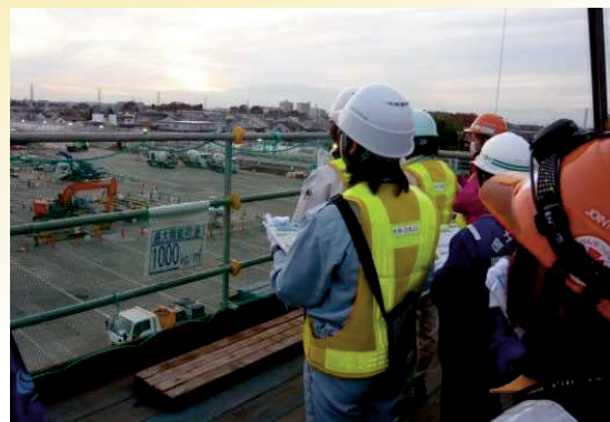
現場点検（安全通路）
