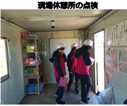
現場休憩所の点検
