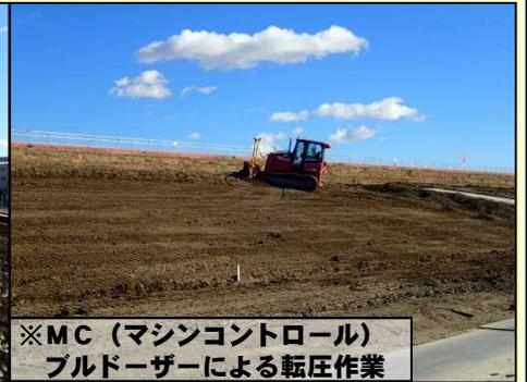
※MC（マシンコントロール）ブルドーザーによる転圧作業
