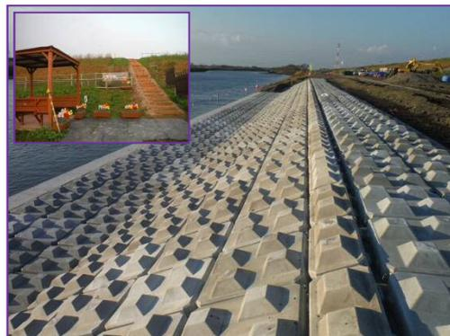
護岸用ブロックの法面部分を設置完了した様子です(H28. 1. 15)
