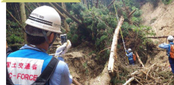
【H26.8 広島土砂災害】 (広島県広島市)
