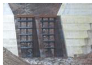
【三号の格子部拡大写真。水の落差が無いことが分かります。】
