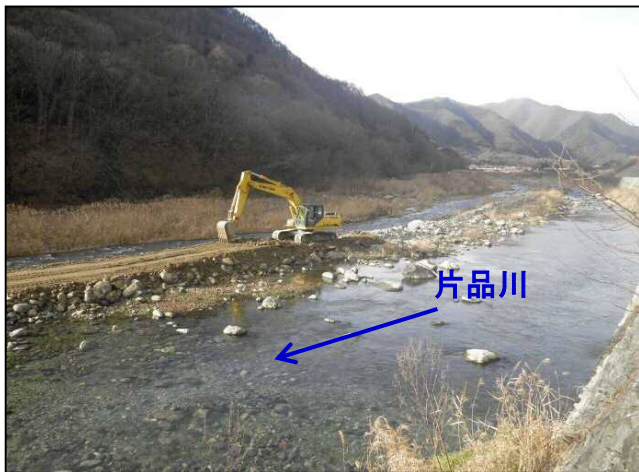
施工現場状況
