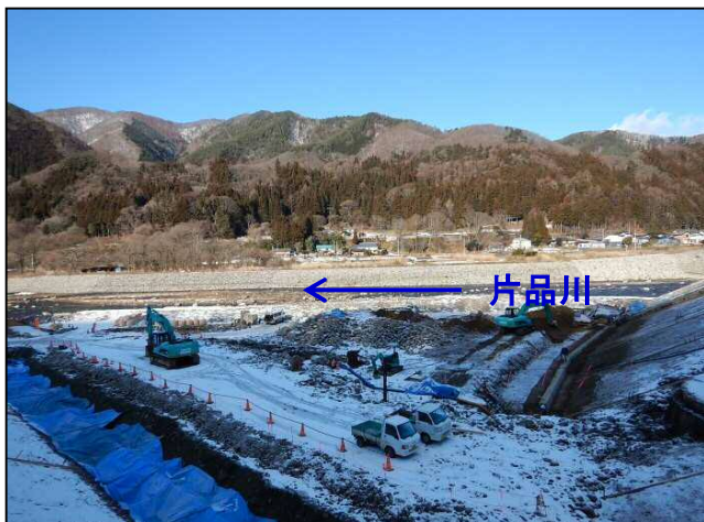
施工現場状況
