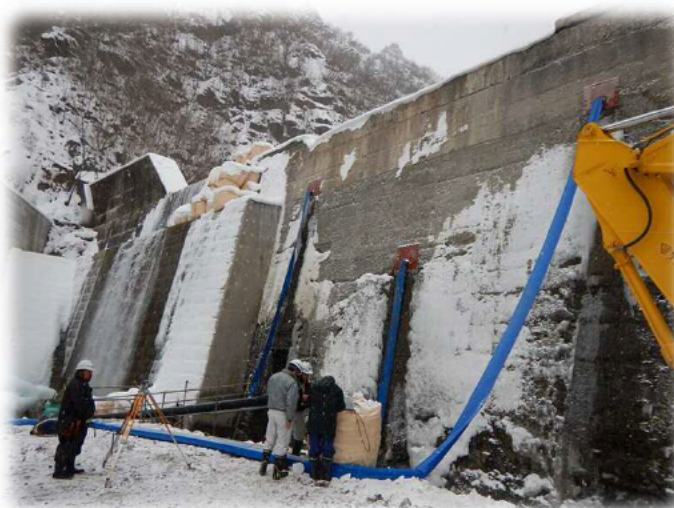
【工事現場の様子（1月20日撮影）】
