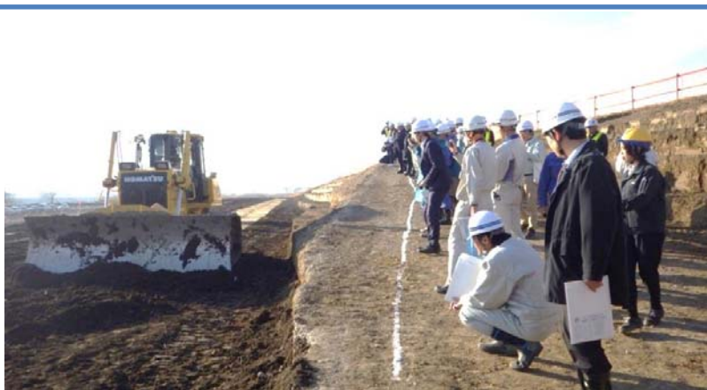
ICT建設機械説明(マシンコントロールブルドーザ)
