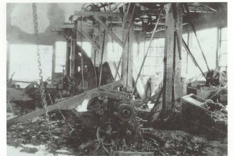
被災した工場の内部 （緑町2丁目）
