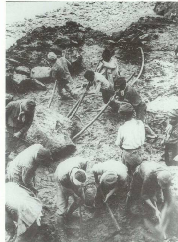
不通となった足尾線の復旧作業状況（東村）
