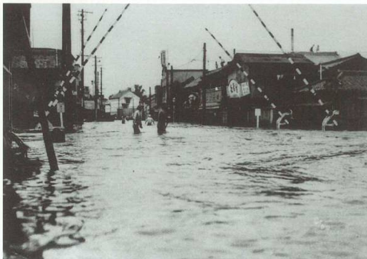
冠水した両毛線の 踏切周辺 (通2丁目)
