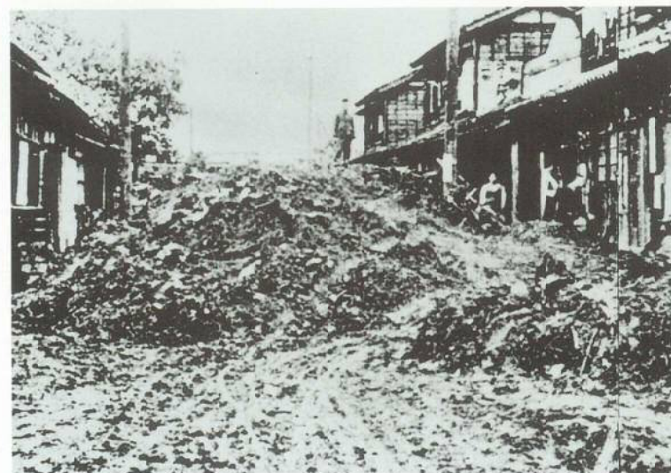
中通りに堆積した 土砂の山 (浜松町)
