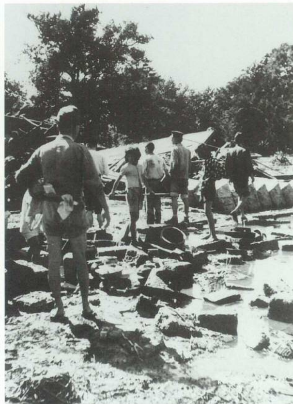
洪水後の被害状況（十念寺地先・足利市）
