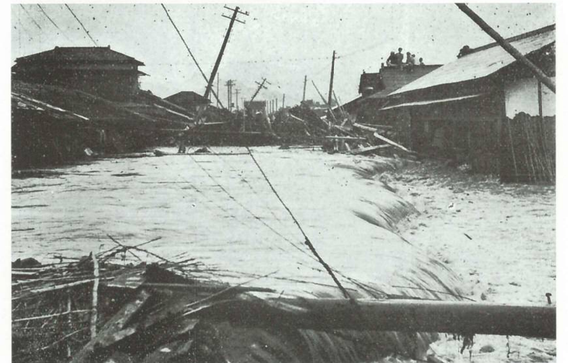
氾濫による被害状況（桜木町付近・桐生市）
