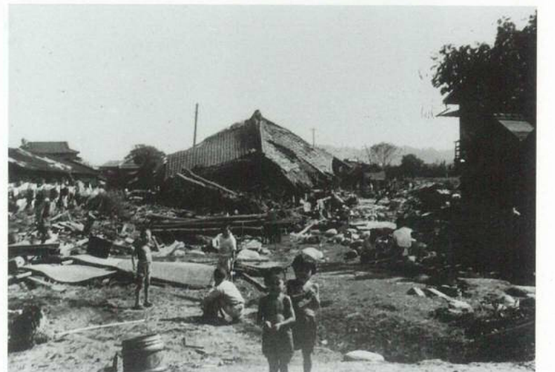
流失・倒壊で家を 失った子供 (桐生市内)
