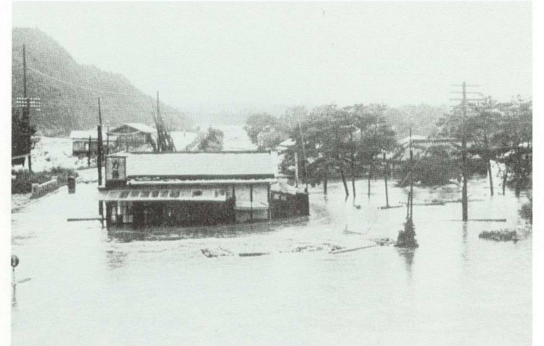
浸水状況（赤岩付近・桐生市）
