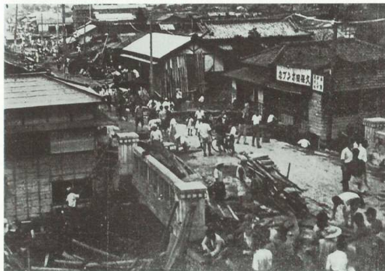
復旧状況 (桜木町久保田ポンプ店 付近・桐生市)
