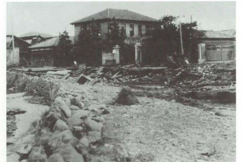
連台寺川の被害状況 （緑町2丁目）
