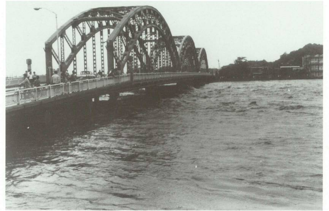
渡良瀬川〔中橋〕の洪水状況を左岸より望む（足利市・南町）
