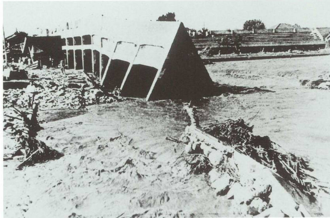
倒壊した新川グラウンドのスタンド（稲荷町）
