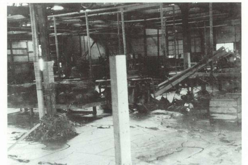
被災した工場の内部 （緑町2丁目）
