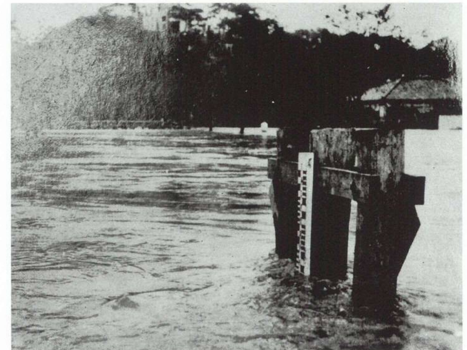
富永公園付近の濁流 (相生町・伊勢町付近)
