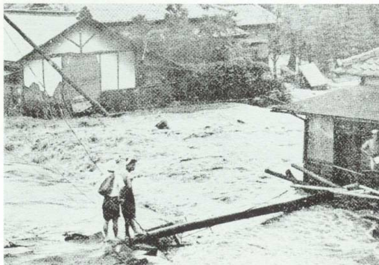
氾濫による被害状況 (桜木町付近・桐生市)
