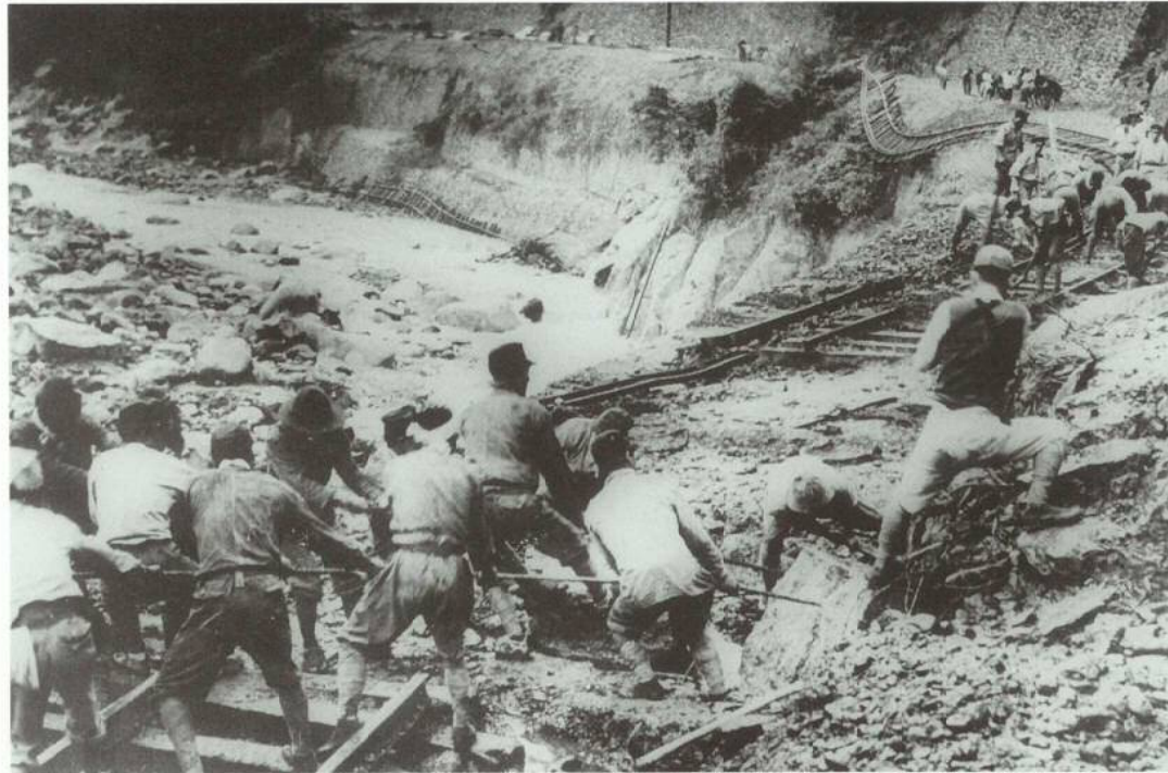
不通となった足尾線の復旧作業状況（東村）
