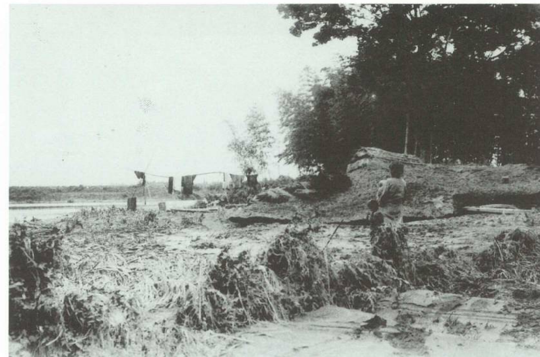
足利郡毛野村付近の被害状況（現・足利市）
