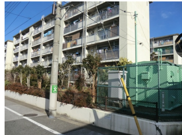
都営新田一丁目アパート1号棟 (5階)
