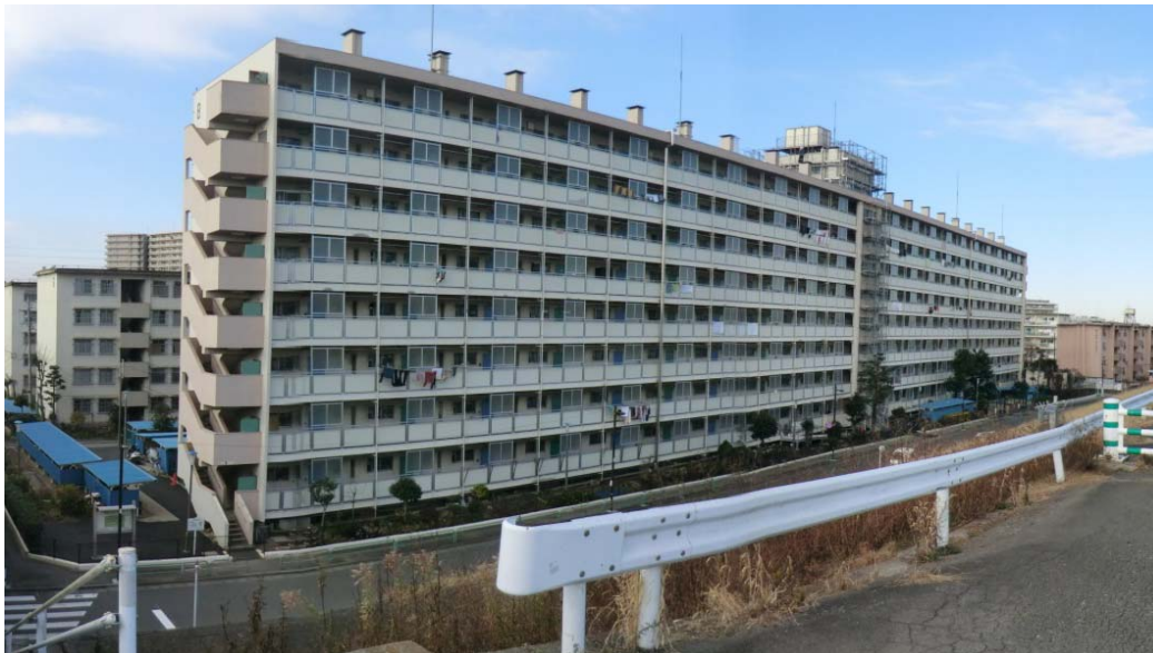
都営新田一丁目アパート8号棟 (8階)
