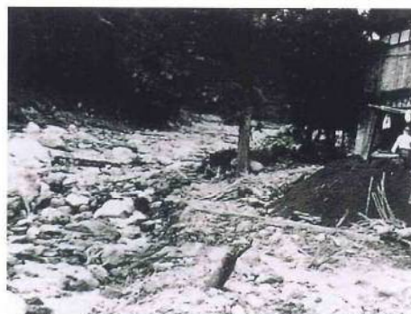
土石流によって被害を受けた梨木温泉 (昭和22年黒保根村)
