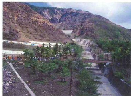
憩いの場として生まれ変わった緑の砂防ゾーン
