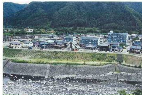
通洞床固群 (足尾町)
