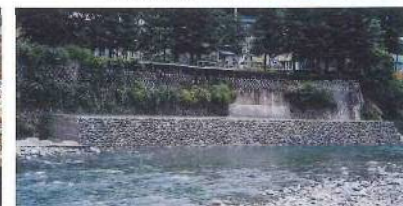
整備された護岸
