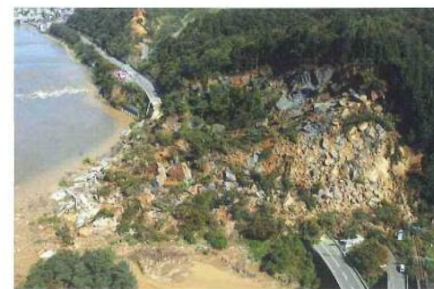
信濃川沿いの山がくずれ、道路をのみ込んだ（新潟県小千谷市）
