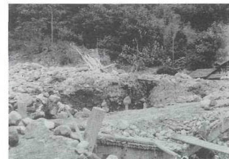
土石流によって破壊された早房橋 (昭和22年黒保根村)
