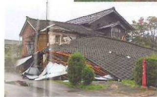
倒壊した家屋（新潟県長岡市）
