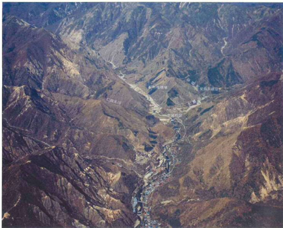
足尾砂防えん堤周辺の荒れた状況
