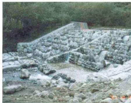
鳥居川上流1号砂防えん堤
