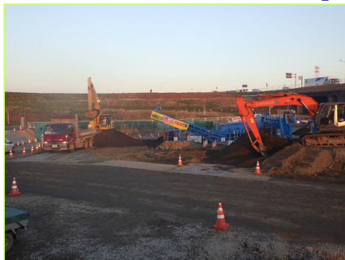
H28. 12. 19日(月)工事現場の状況写真
