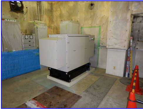
H28. 12. 15日(木)据付け完了状況写真
