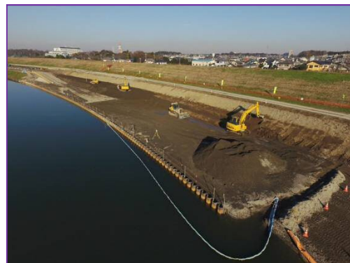
H28. 12. 19日(月)工事現場の状況写真
