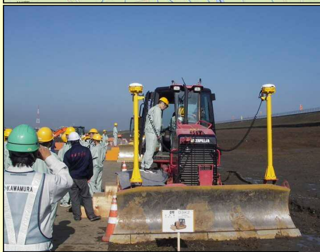
※建設機械(MCブルドーザ)への試乗体験
