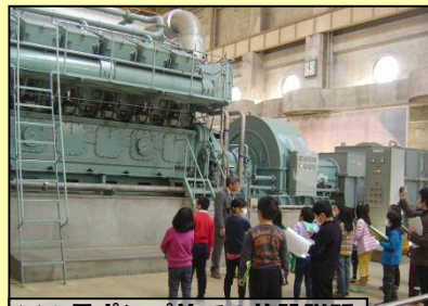
※3号ポンプ前での施設説明
