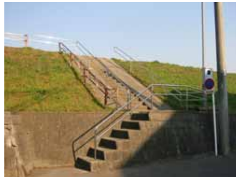
図 3-5-14. 用地に限りがあるため、勾配が急な階段（新羽橋上流左岸）
