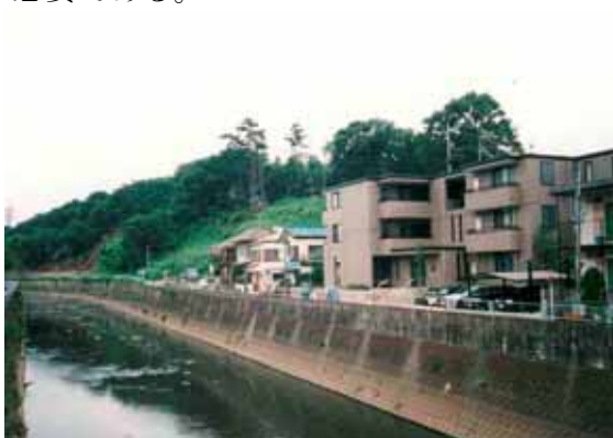
図 3-4-5. 矢上川市街地区間 水面まで 5m 近くある。河川沿いは狭く消防車の進入が困難である。
