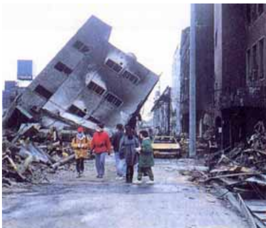
図 3-4-1. 阪神淡路大震災被害状況 (JR新長田駅前)
