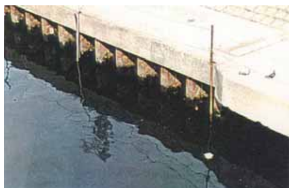
図 3-3-5. 直立護岸の水際部（鋼矢板護岸）
