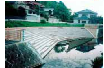
砂田川に設置されている消防水利としての取水ピット
