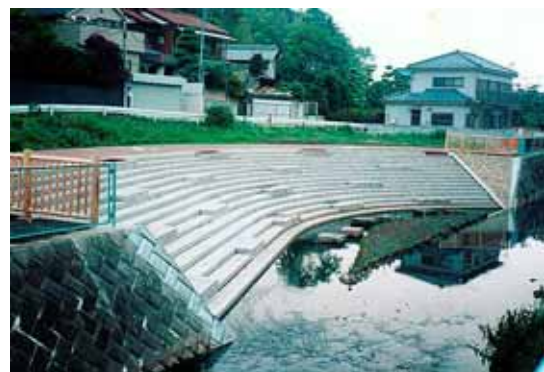
取水用ピットが設置されている階段 (横浜市港北区砂田川)
