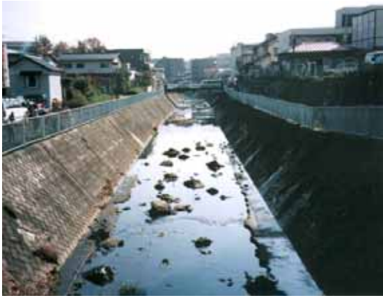
図 3-5-3. 早淵川上流 水際部へのアクセスが困難な急傾斜護岸とフェンス
