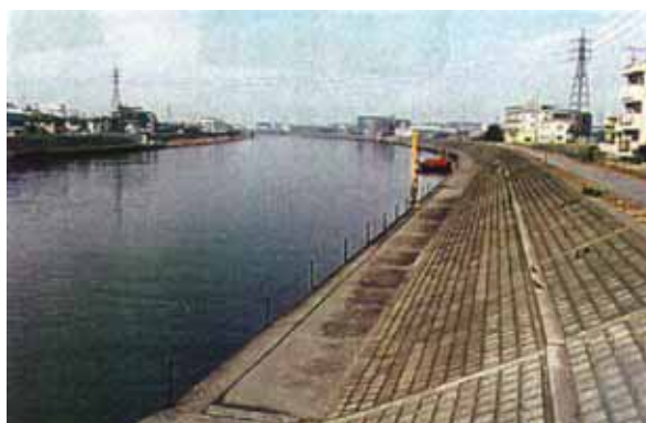
図 3-3-4. 末吉橋上流左岸のコンクリート護岸
