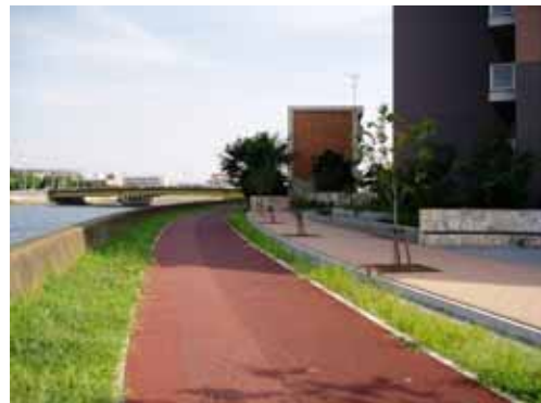
図 3-5-12 芦穂橋上流右岸 (公開空地の誘導)
