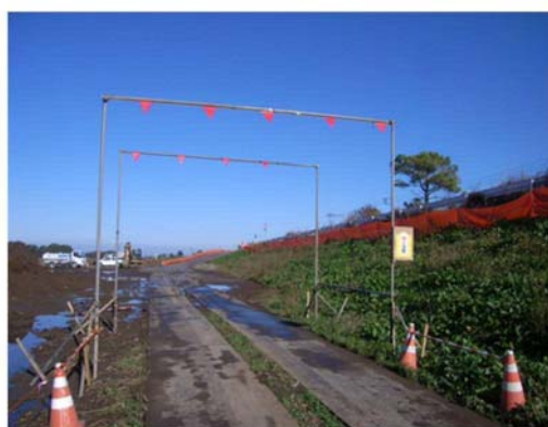
防護対策(門柱ゲート)の設置
