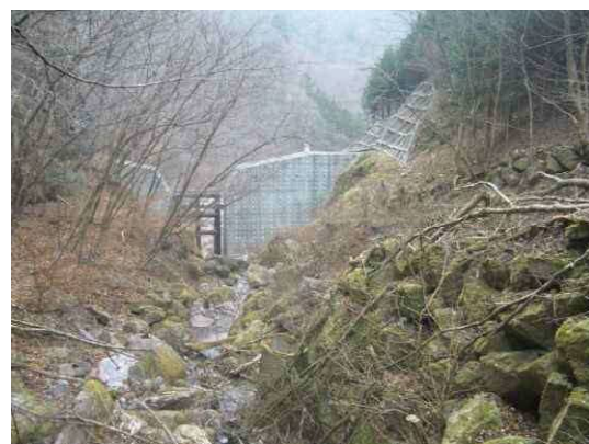
[堰堤上流部(上流より)]
