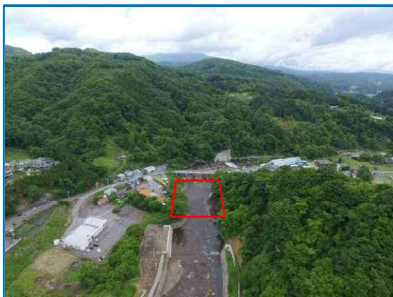
写真－1 工事箇所（赤） 上空上流より
