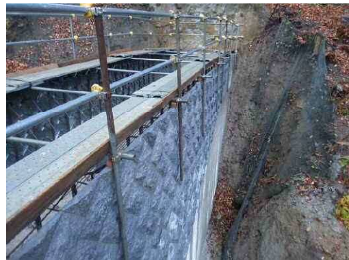
【写真-③】型枠外側の状況
