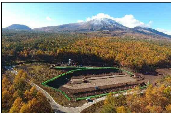
下流より望む濁沢第二砂防堰堤（施工時）
