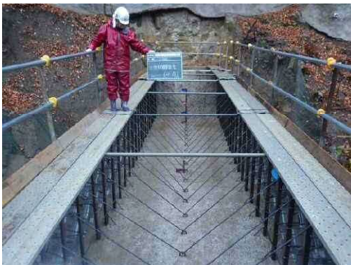
【写真-②】施工内部の状況
