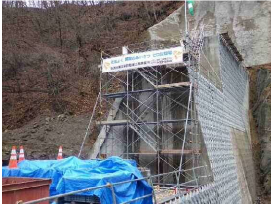
【写真-④】枠組足場昇降設備設置状況
