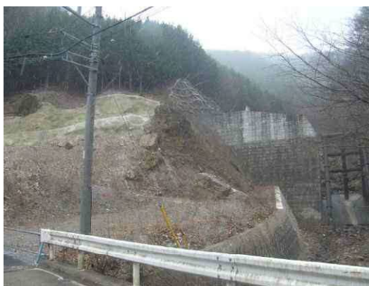
[堰堤下流部(下流より)]
