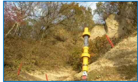
写真-7 警報センサーの設置
