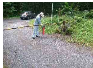
水道探査状況
