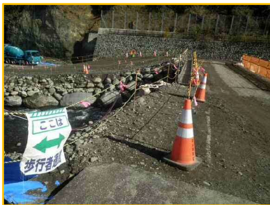
【写真-4】 歩行者通路（仮橋）
