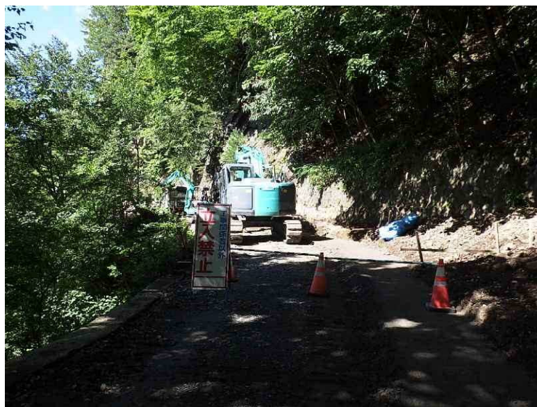
重機稼働中立入禁止柵を設置
