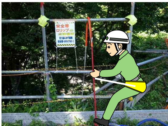
写真3-6 安全帯ロリップ点検設備
