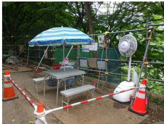
写真3-7 熱中症対策設備
