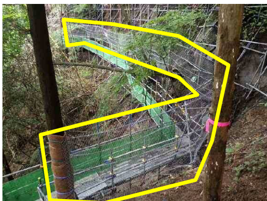
写真3-4 仮設落石防止ネット
