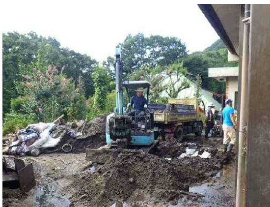
写真4-1 災害対応状況
