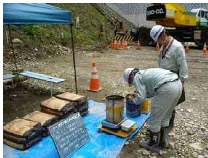
写真-2 材料確認 (谷沢川第5砂防堰堤)
