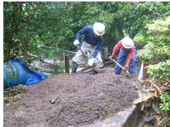
写真4-2 災害対応状況
