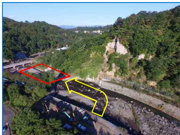
写真-3 工事箇所（赤）及び進入路（黄）
