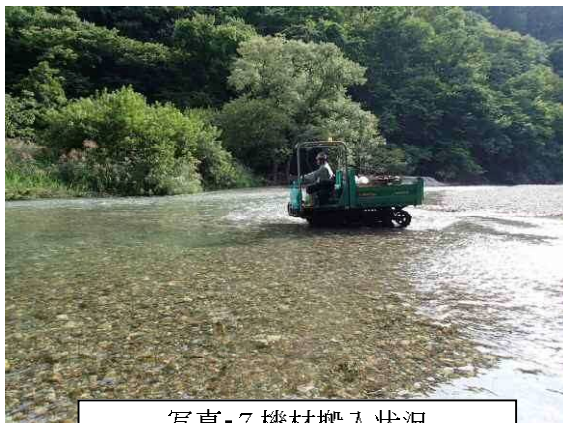
写真-7 機材搬入状況
