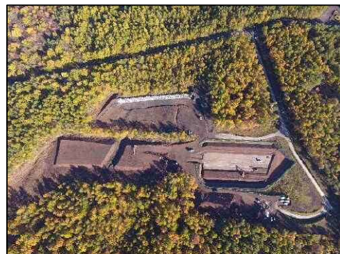
現場上空より望む濁沢第二砂防堰堤（施工時）
