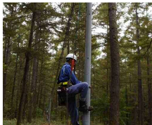
図 3-5 ベルブロック使用状況②
