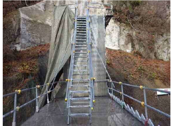
【写真-⑤】フリーステップ階段設置状況
