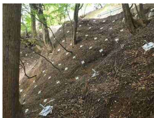
写真2-2 施工完了状況
