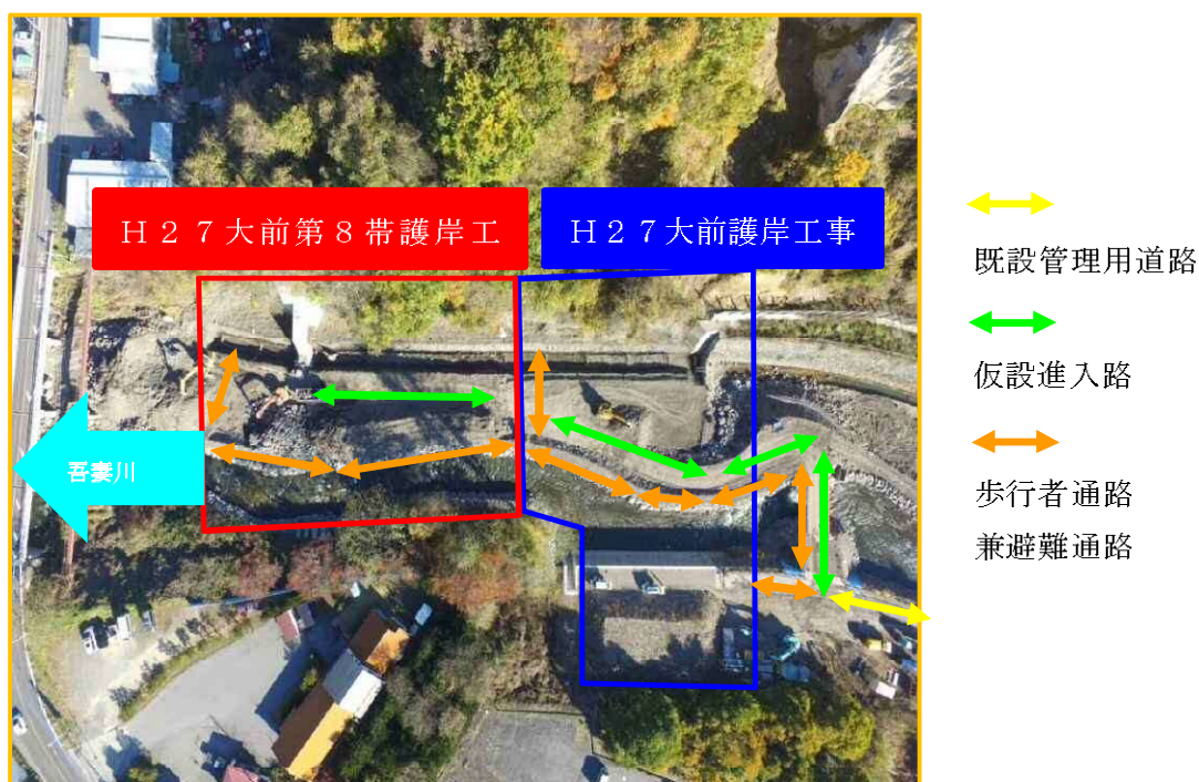
【写真-3】 仮設進入路及び歩行者通路兼避難通路 上空写真
