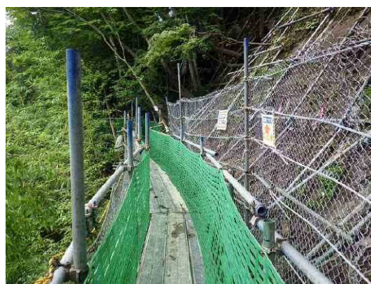
写真3-3 安全通路設置状況
