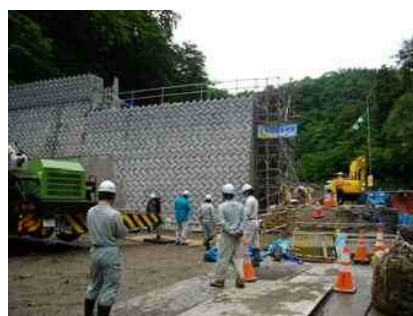
写真-8 安全パトロール （谷沢川第五砂防堰堤工事）
