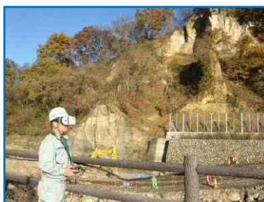
写真-5 360°FPV飛行点検
