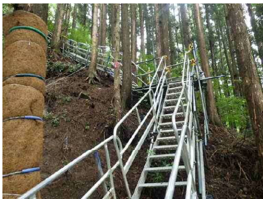
写真3-2 昇降設備設置状況
