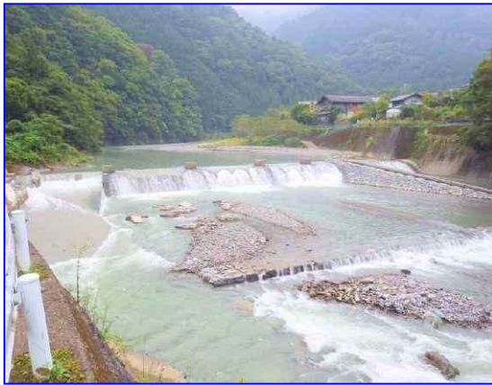
写真－１ 着工前（右岸下流より）
