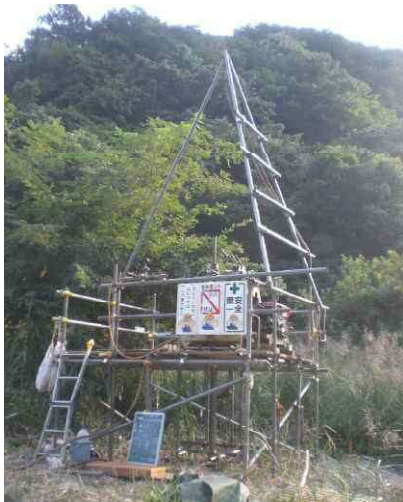
写真-1 ボーリング足場全景
