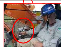
（無線機を用いての OP 相互の合図・確認）
