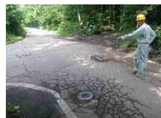
路面調査状況
