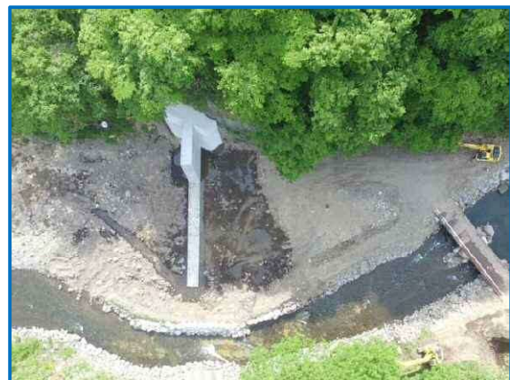
写真－2 帯工右岸完成時 上空真上より
