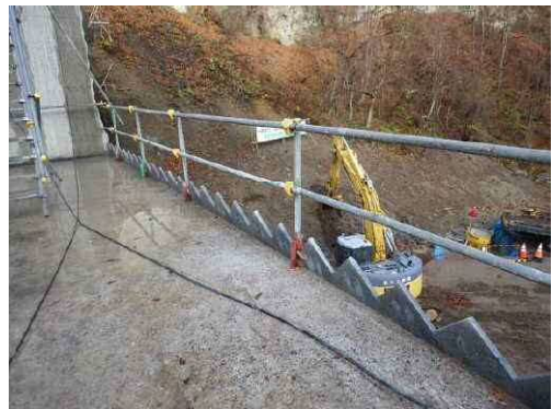
【写真-①】施工途中の手摺り設置状況
