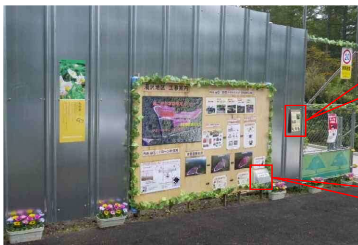
（現場出入口における周辺住民への工事説明掲示等）
