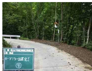
カーブミラーを設置する
