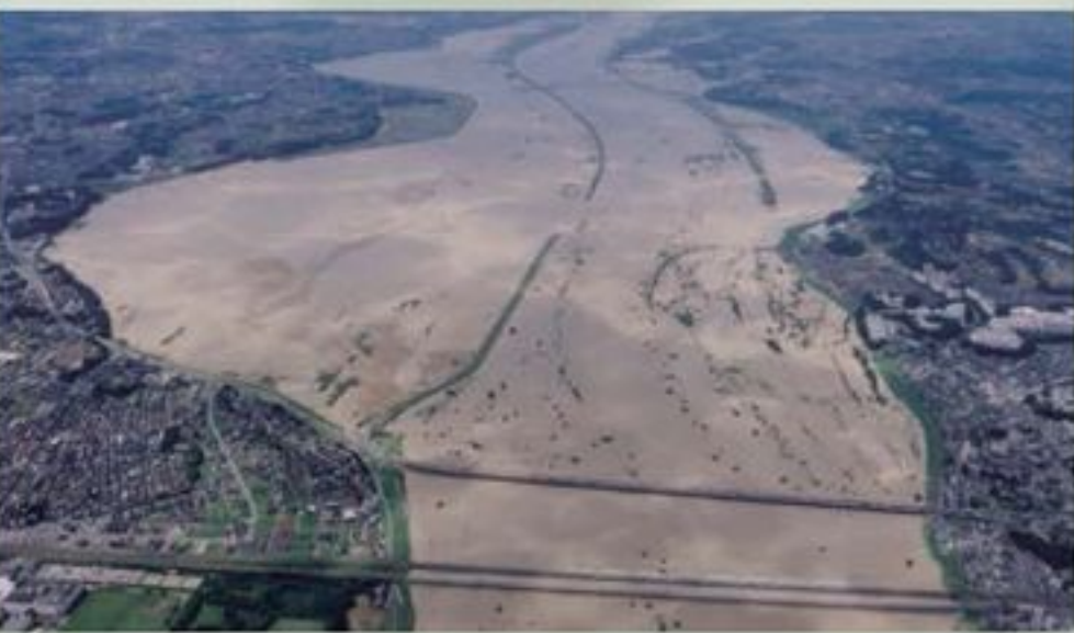
田中調節池・稲戸井調節池
