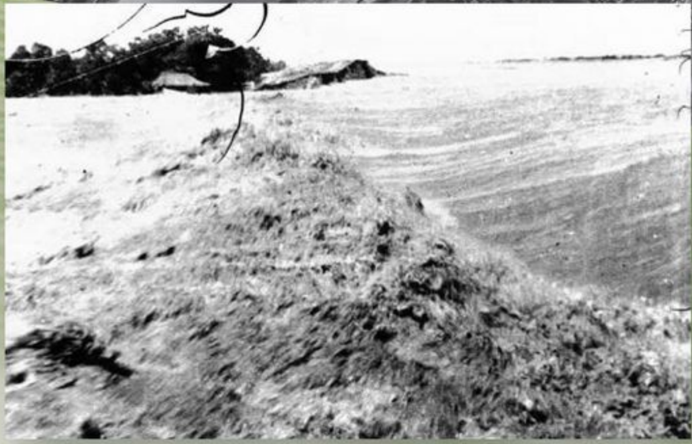
利根川決潰口からの濁流
