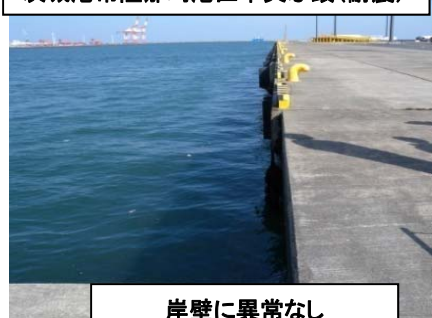
茨城港常陸那珂港区中央ふ頭(耐震)
