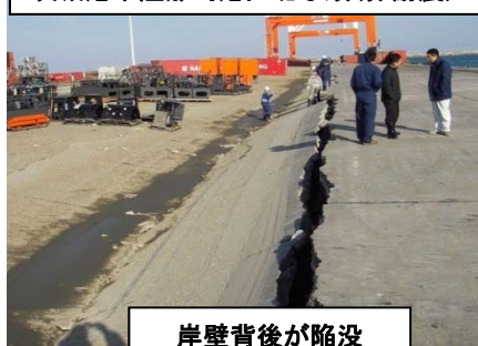
茨城港常陸那珂港区北ふ頭(非耐震)
