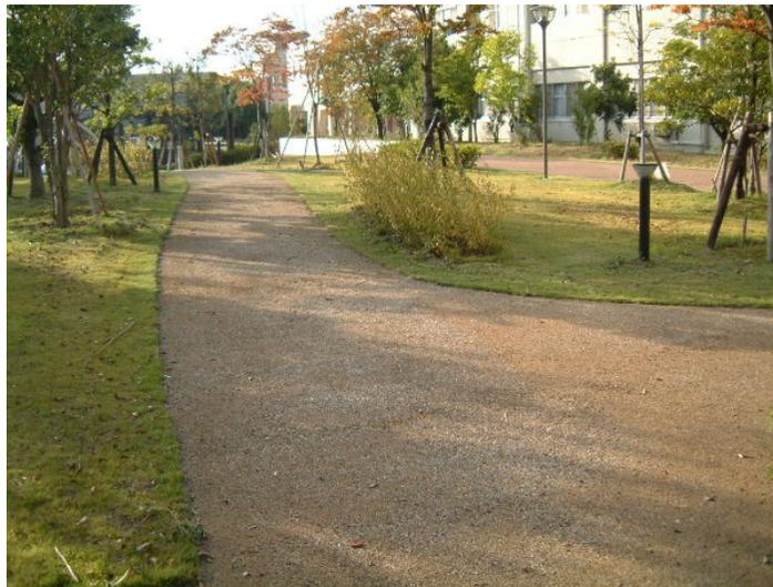
type-B 散策路（幅員2m）
